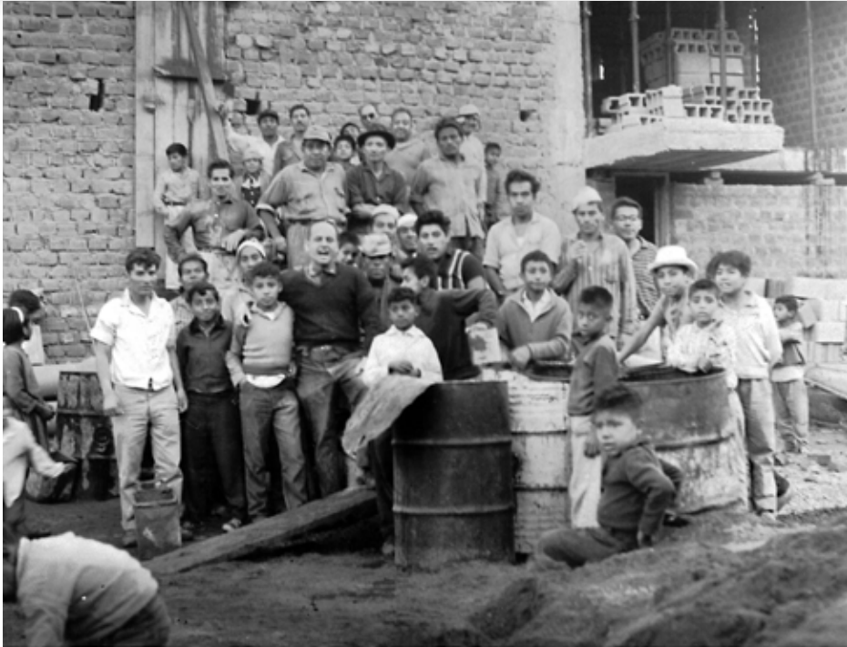
Jorge Álvarez en la construcción del templo parroquial de Tres Compuertas
