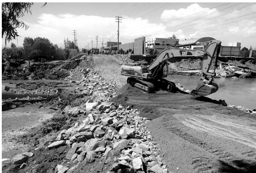
Durante el programa de reconstrucción no se avanzó suficientemente en la rehabilitación o reconstrucción de las defensas ribereñas, lo que puede tener consecuencias en las temporadas de lluvias como la que se está iniciando.
