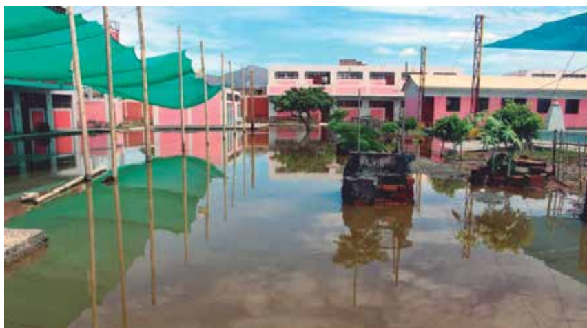
La infraestructura de educación sufrió también los efectos de las lluvias, inundaciones y huacos; quedaron destruidas 250 instituciones educativas y casi 2500 fueron afectadas.
